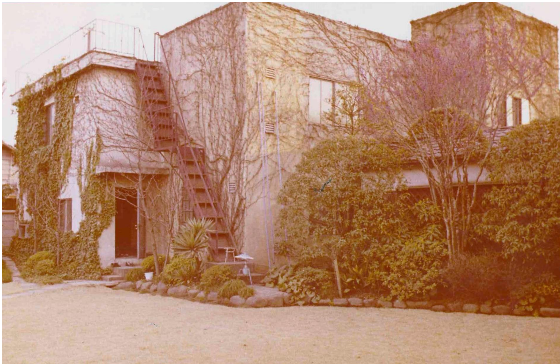
昭和30年に建てられた書庫
